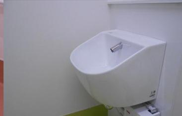
シンクを深くし汚染された水の飛散を防止
