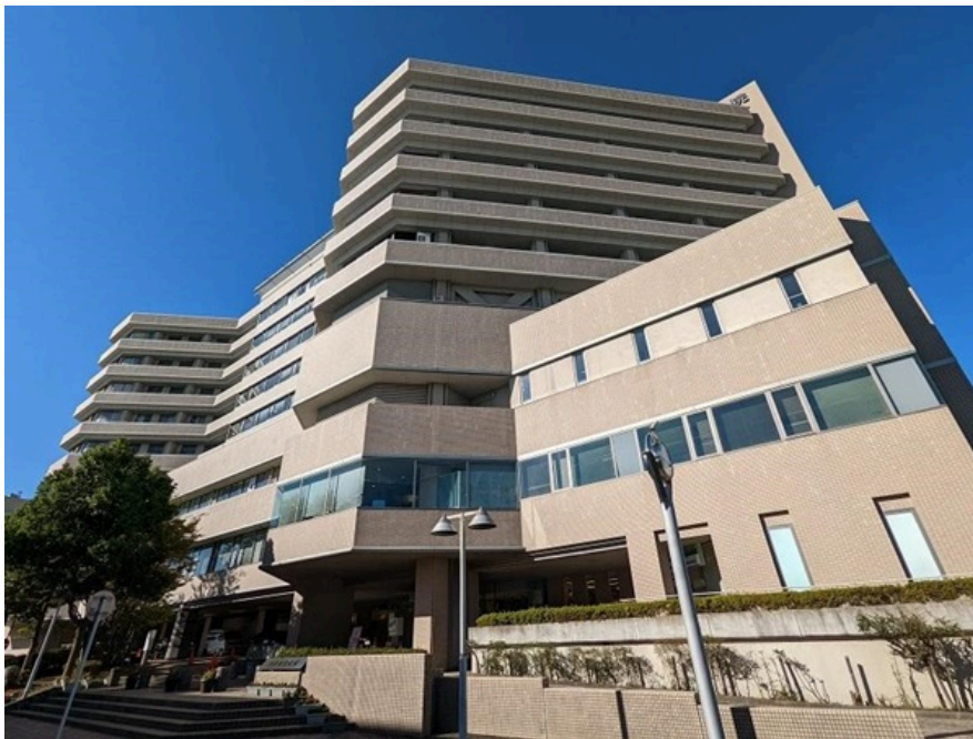
市立大津市民病院の外観
